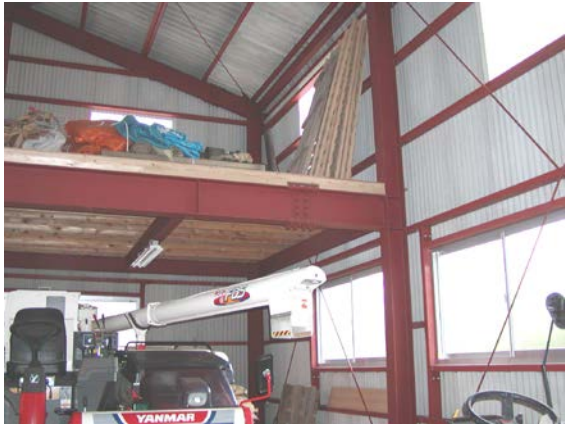
作目：共通 作業：圃場・施設管理 目的：施設整備 方法：倉庫の上部の空きスペースに棚を設置。
