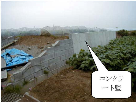
コンクリート壁
