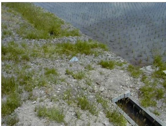
段差を解消した圃場出入口
