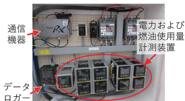
▲写真 イチゴ栽培温室における用途別電力使用量・燃油使用量の計測の様子
