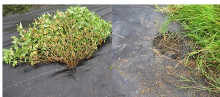
ピン穴から雑草発生 草刈機による損傷
