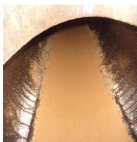
図 2 - 6 泥が堆積した配管内の様子
