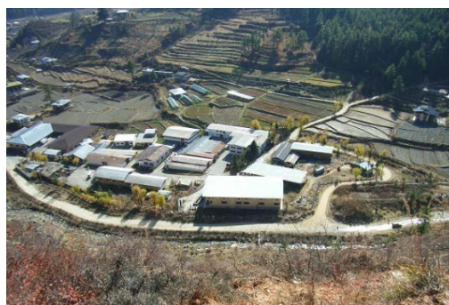
図1 農業機械化センター
