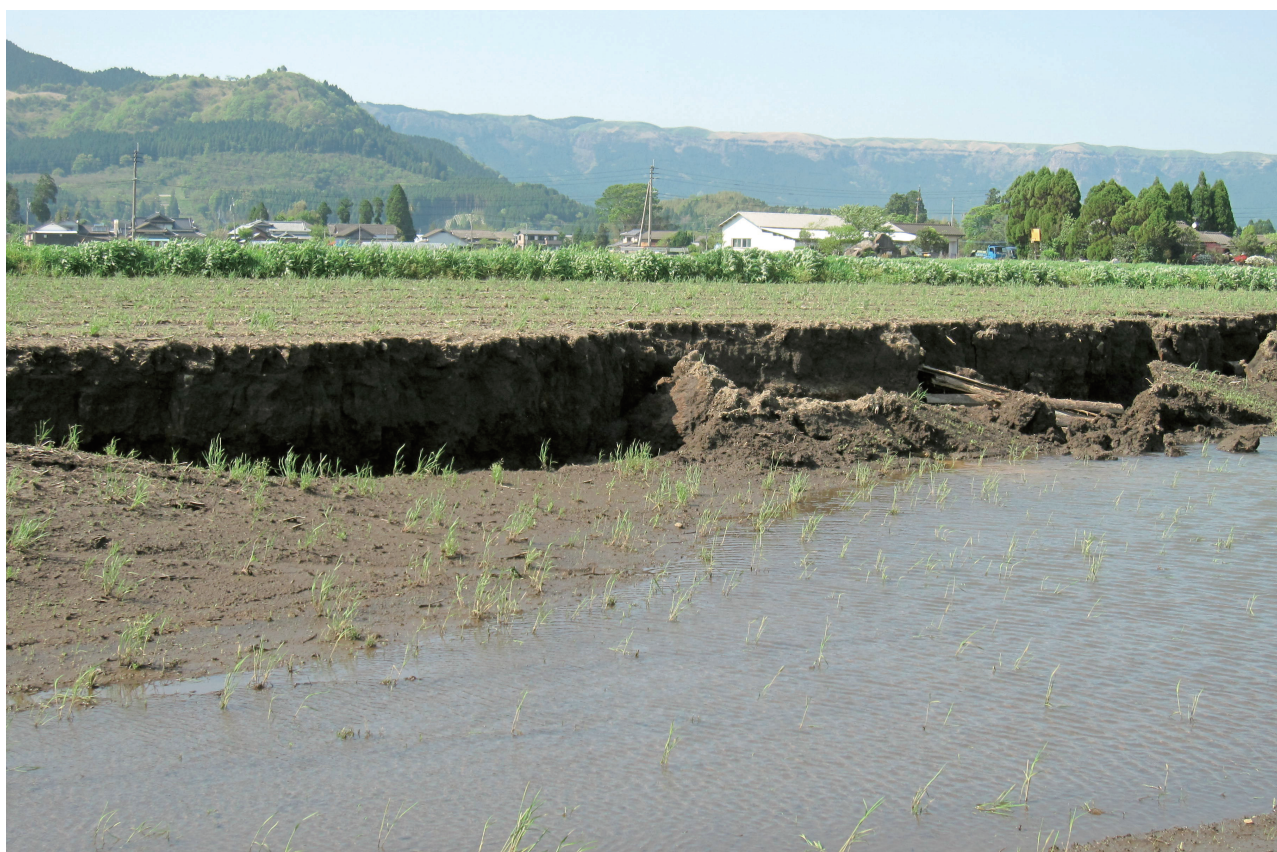
熊本地震による被害
