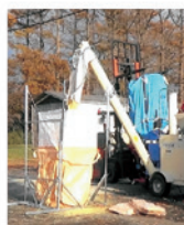
破砕機をストップして、満杯フレコンを交換
