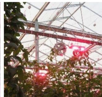
図 10 LED による補光
