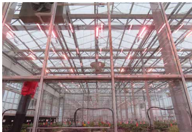
図 3 LED による補光
