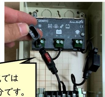
ウォールボックス内に充放電コントローラをねじ止めします。電線の取り回しを楽にするため、なるべく上に取り付けます。もし端子台があればウォールボックス内に取り付けます。充放電コントローラのバッテリー側と、負荷側のマイナス極は「ヒューズ」を取り付ける必要があります。ヒューズは自動車用のカーヒューズで構いません。端子台を設置する場合は「平型」か「ミニ平型用」のものを使用すると良いでしょう。端子台を設置しない場合はスペースに余裕があるので、ガラスヒューズ用のものでもかまいません。入手しやすいものを利用してください。なお、制作時には充放電コントローラの説明書をよく読み、指示に従ってください。
