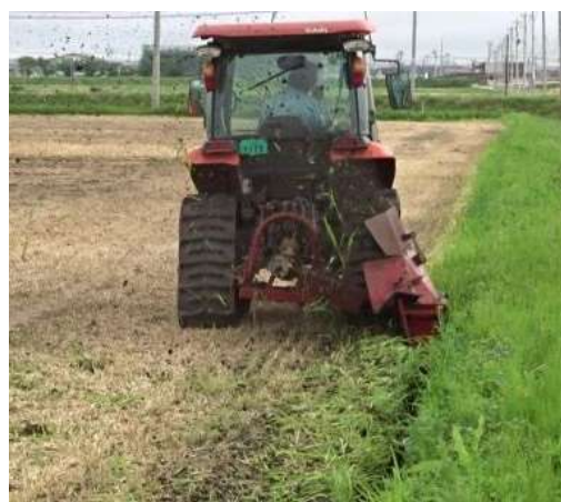
図V-9 額縁明渠の施工
