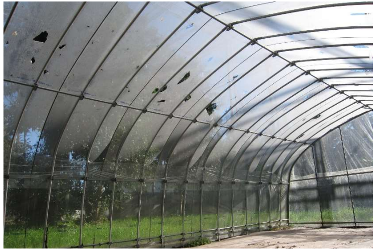
図 I - 5 テグス峰 1 本張りでのフィルム損傷状況（農ビ）
