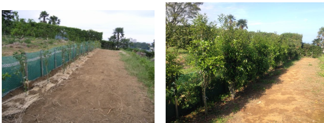
2012 年 6 月 2015 年 4 月 同位置から撮影（左：土止め柵の高さ 1 m、右：手前樹は 2 m 近くに生長）
