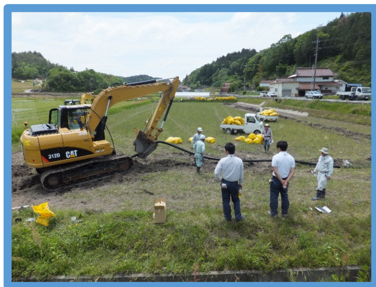
世羅町黒淵でのフォアスの施工風景
