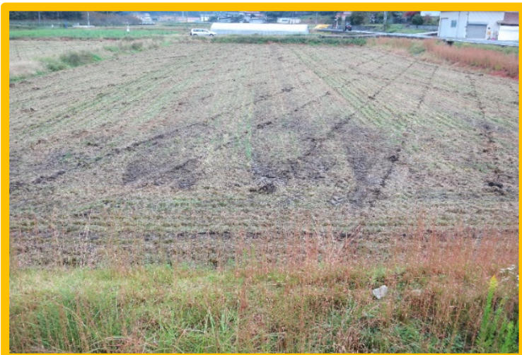
弾丸暗渠施工 2013年10月15日
