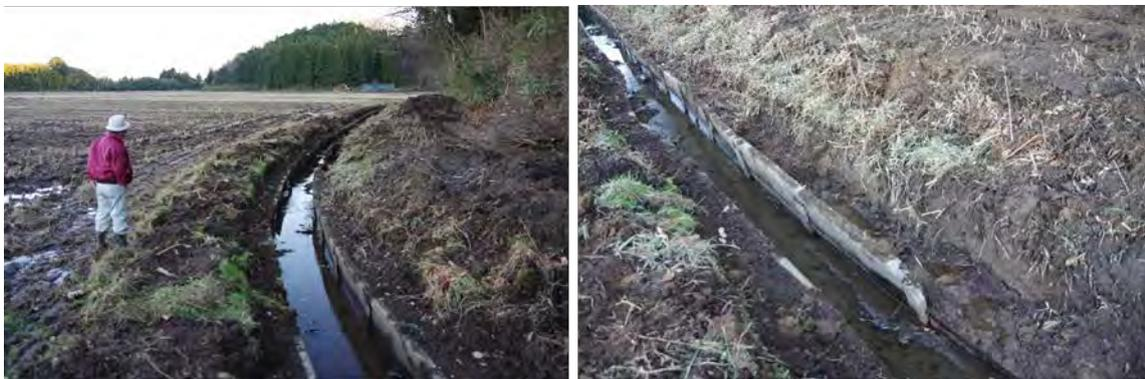
図 4-15 土壌流出をおこし水路法面が崩壊した二面張り柵渠水路
