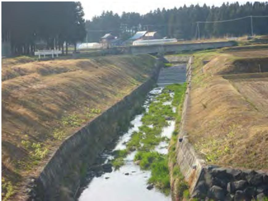
図 4-11 土砂の堆積により遷移が進んだ幹線排水路
