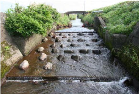
図4-2 粗石付き斜路式魚道の概観
