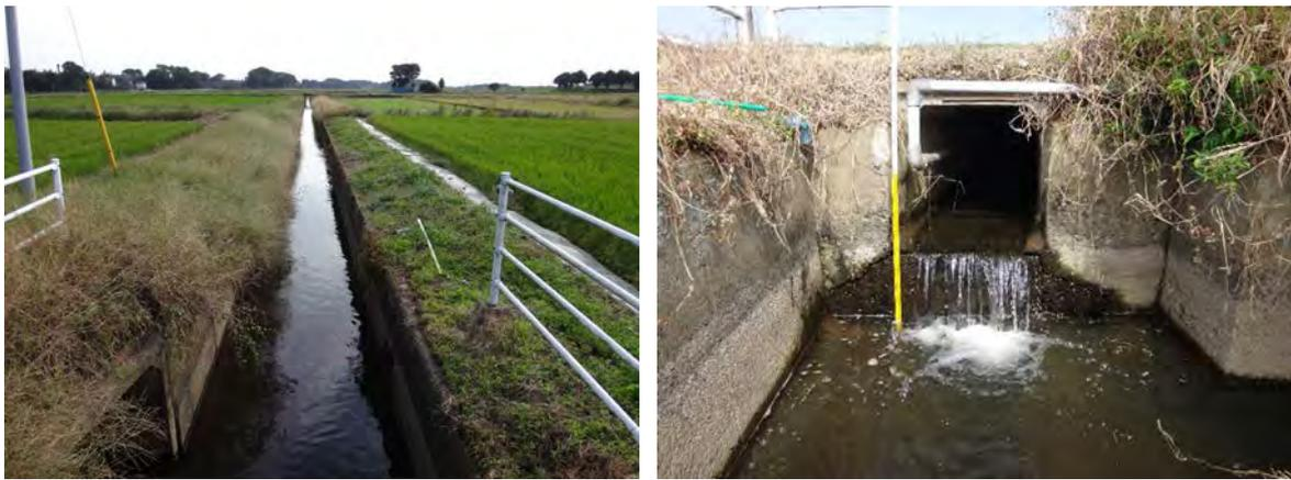
図4-8 落差工解消対照の支線排水路
