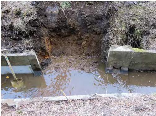
図 4-17 ベンチフリューム設置場所の掘削
