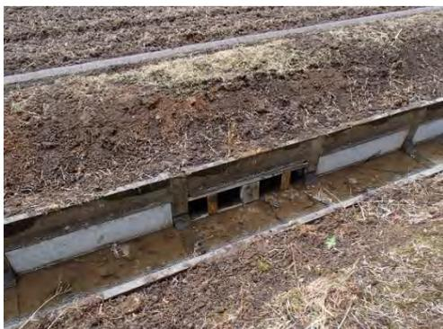
図 4-19 生態系配慮工法 1 完成状況
