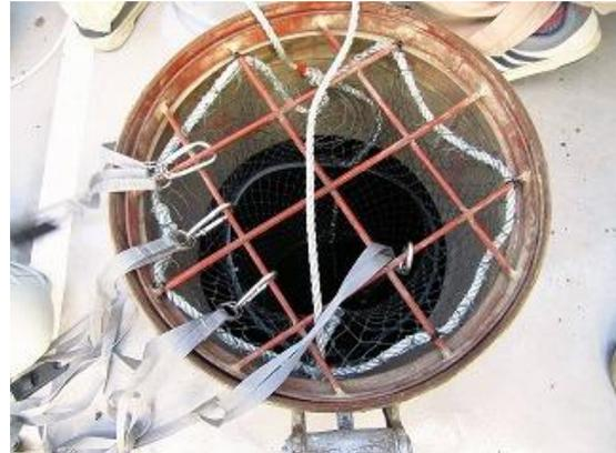
図18 サイロ上マンホールを使用した投薬設備
