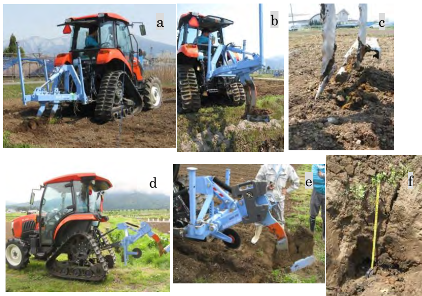
カットドレーンおよびカットドレーン mini の施工時の様子 a)、b)、c) : カットドレーン d)、e) : カットドレーン mini f) : カットドレーン mini 施工後の土壌断面
