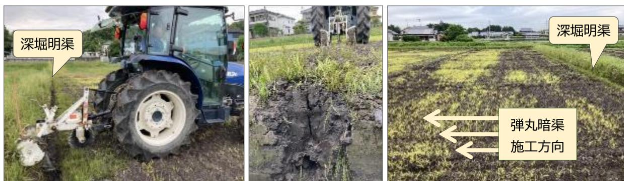
図Ⅳ-4 サブソイラーを用いた深堀明渠連結弾丸暗渠の施工
