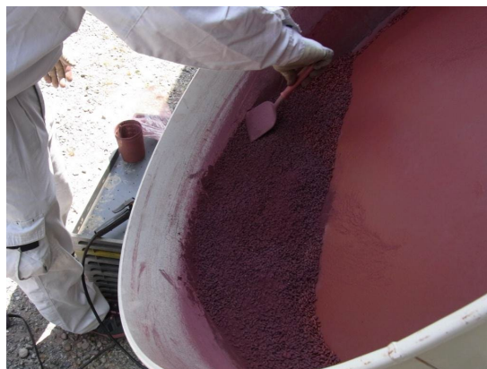
④ さらに少しずつ資材をかけて、同様に付着させる（②③④の繰り返し）
