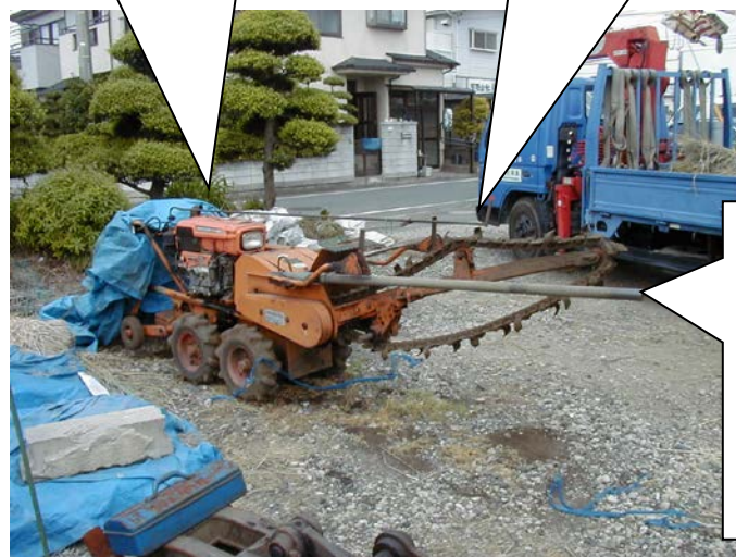
方向修正パイプ等を取り付けたトレンチャー
