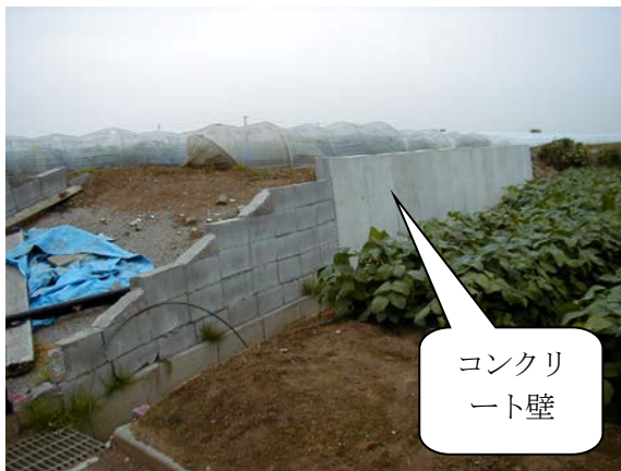
コンクリート壁
