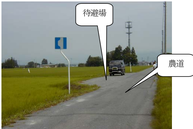
待避場を設置した農道
