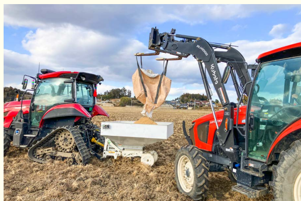
有材補助暗渠の施工
