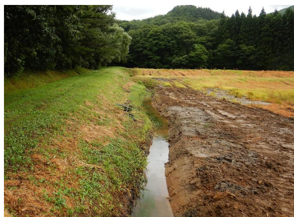
図 I-12 台地からの侵入水を受ける明渠
