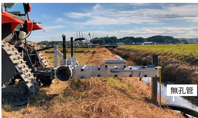
図 I -8 落水口施工の様子
