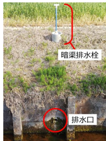
図Ⅲ-7 暗渠排水栓と排水口
