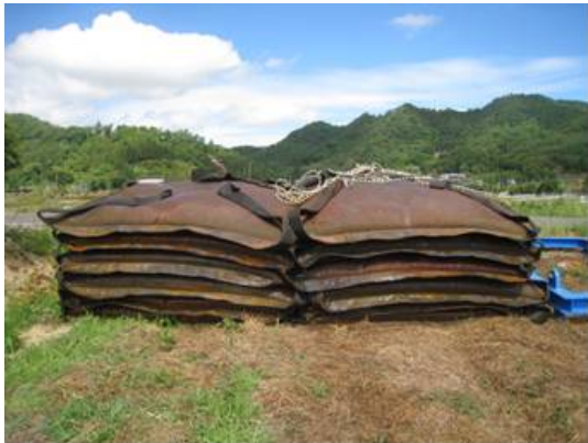
図 I -3.18 積み重ねによる自重脱水
