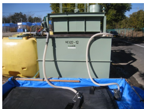
図 I -3.12 中和凝集槽での処理
