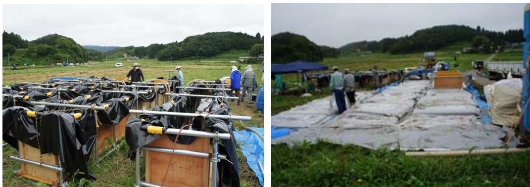
図 II-3.9 沈殿槽(木製)と大型脱水袋(平成 24 年 8 月、福島県飯舘村)
