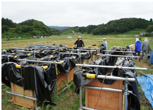
貯留槽で凝集沈殿
