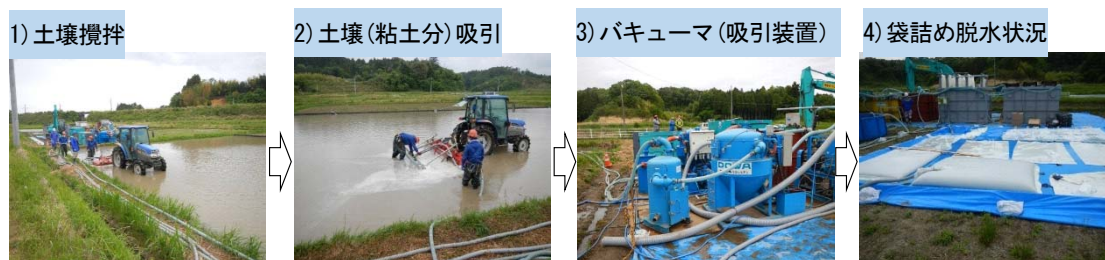
図 3.14 福島県南相馬市での現地試験の流れ(平成 25 年 5 月)
