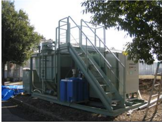
図 I -3.20 高度濁水処理装置
