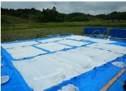
(c)脱水ヤードの整備
