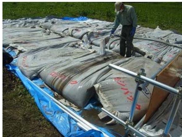
図 II -3.13 ロジパック内の土壌の積み重ね自重脱水
