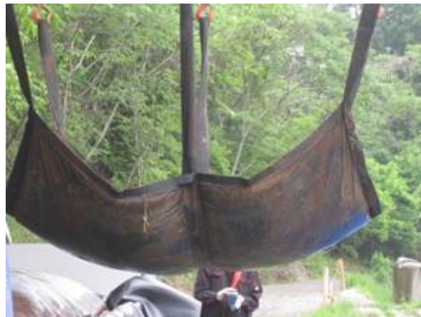
図 I -3.22 脱水袋の荷吊りと運搬
