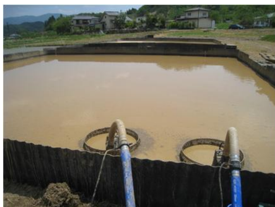
水中ポンプによる原泥水の流送
