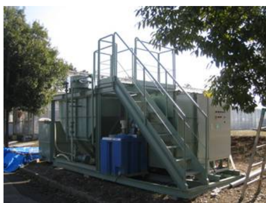
高度排水処理装置
