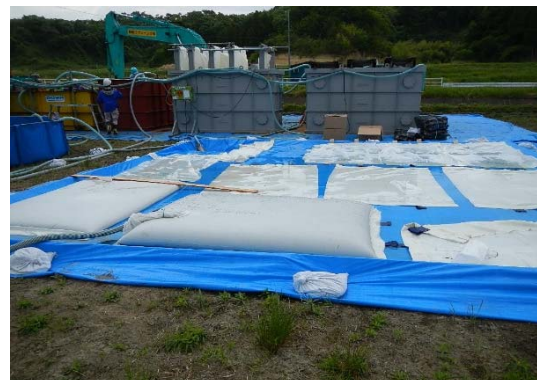
(d)貯留槽の配備
