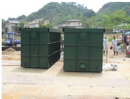
敷き鉄板とノッチタンク
