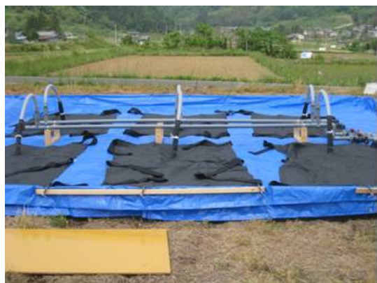
脱水袋の設置
