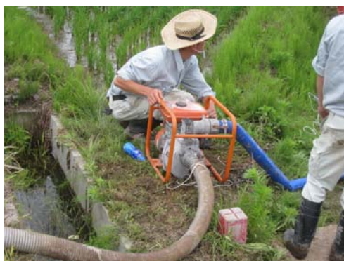
図 I-3.3 エンジンポンプによる導水系確保
