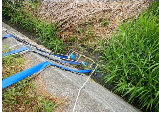
水中ポンプによる給水
