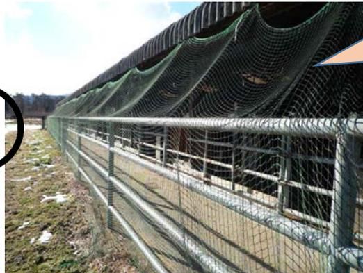
写真は防鳥ネット（角目3cm）を牛舎側面に取り付けた状態
