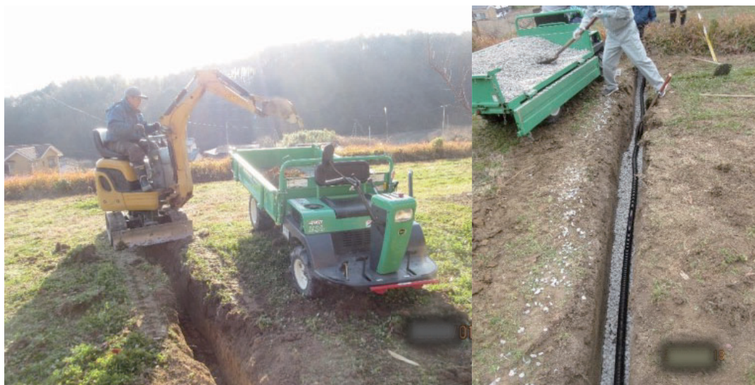
モモ - 図 22 暗渠の設置作業の様子（岡山県）
