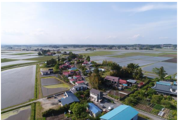
図 20 小型 UAV 空撮による地区の俯瞰画像の例 （宮城県大崎市）
