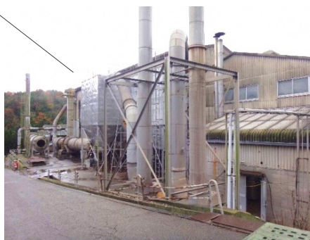
【工場外観:クーラー、集塵機など】
