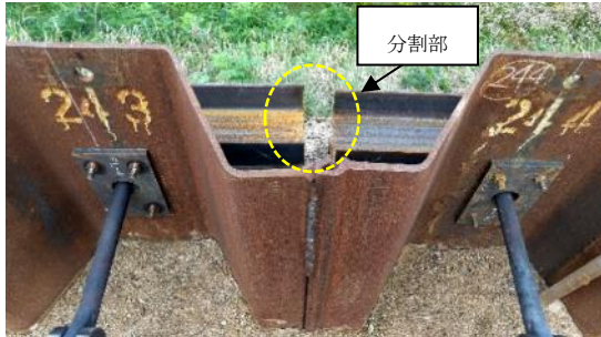
写真-参 3.1 分割した腹起しの設置状況
