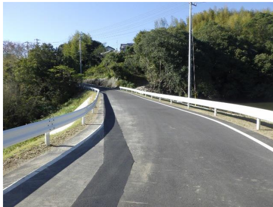
写真 2 施工後の天端道路の様子
