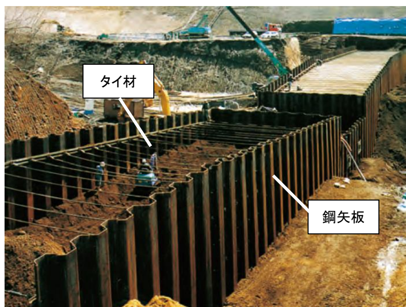
写真 1 鋼矢板による砂防ダム施工の様子 7)
