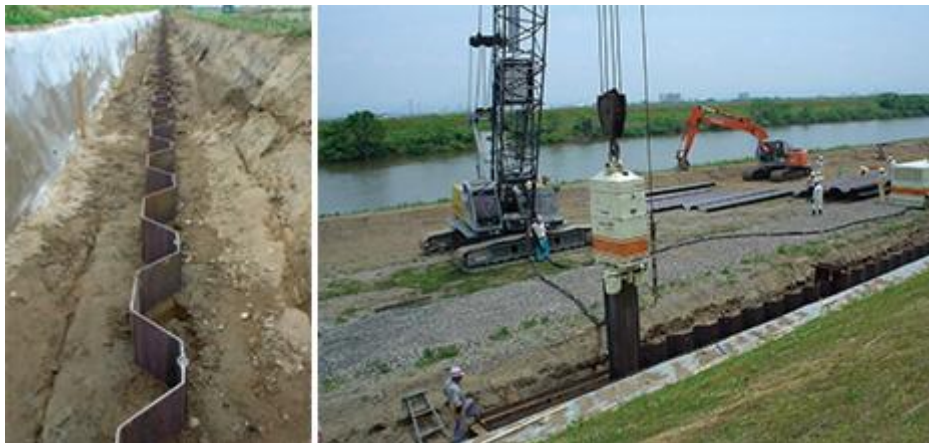
写真 4 バイブロハンマ工法 7)
