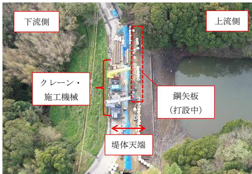
写真 6 施工現場全体の様子
