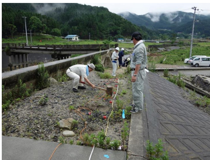
写真-参 2.1 表面波探査の作業の状況
