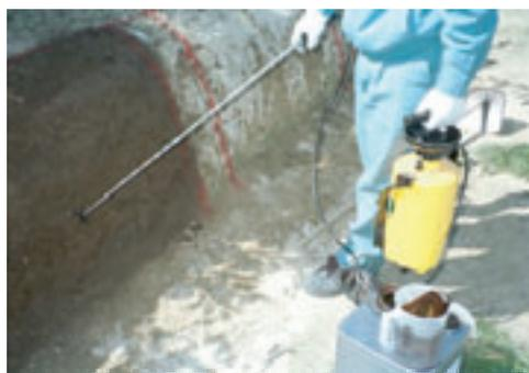
写真7 液体マルチの散布状況
