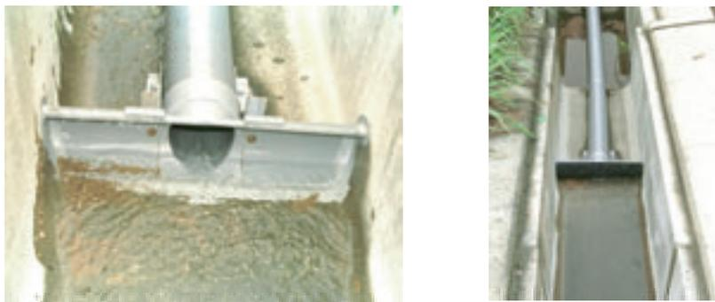
写真4 塩化ビニルパイプ継手を利用した水路内取水装置
