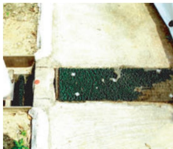
写真3 ポリプロピレン製排水資材
