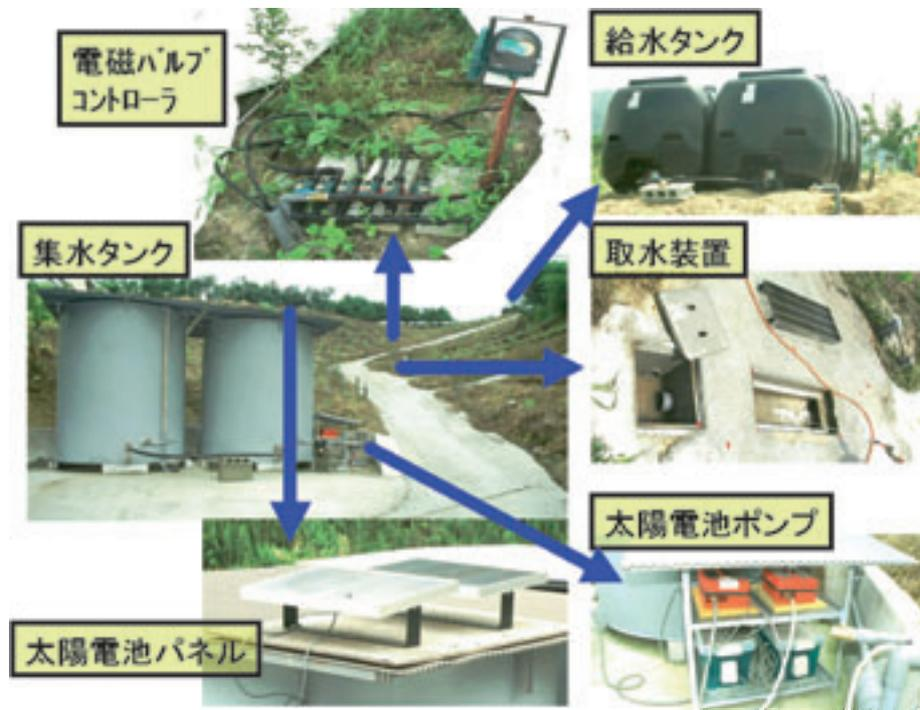
図5 導入器材の概要
