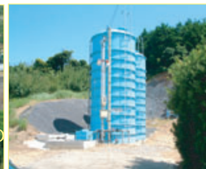
図8 法面からの雨水を利用した貯水(和歌山県)
