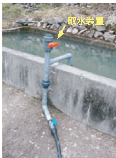
図5 既設水槽からの取水と取水装置の例(サイホン式)
