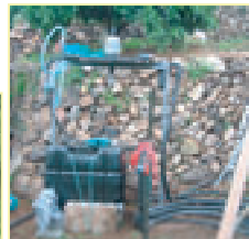
液肥混入・自動制御装置設置
