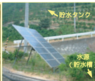
図7 太陽電池を利用した傾斜地園揚水システム
