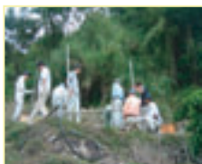
水源設置作業
