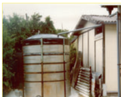
図6 作業小屋屋根からの雨水の貯水
