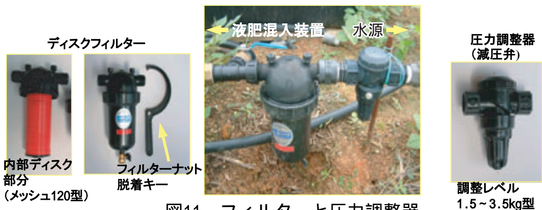
図11 フィルターと圧力調整器 【水圧が高すぎる場合は圧力調整器を設置し、水質保持のためフィルターを取り付ける】
