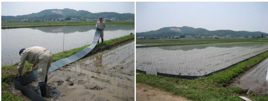
第1-15図 畦畔板の設置
