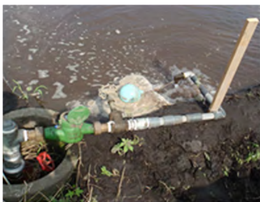
写真 5 フロート式止水弁
