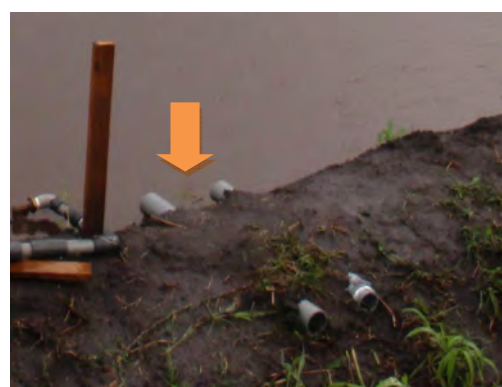
写真 6 ドレンパイプ
