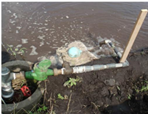
写真 5 フロート式止水弁
