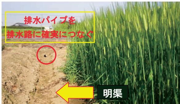
図3 明渠設置の様子
