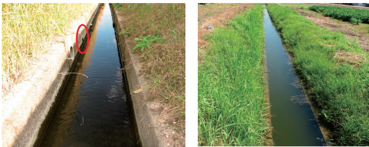
図1 排水路水位と暗渠の出口の状況
