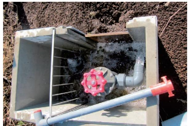
図1 マス内の穴へ直接給水
