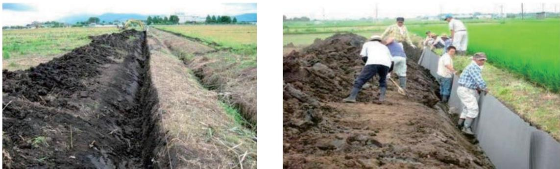
図1 隣接圃場への漏水を抑えるための遮水シートの施工風景
