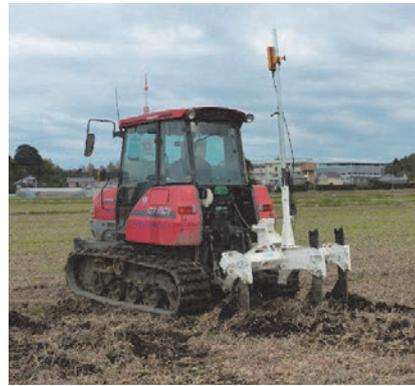
図2 弾丸暗渠の施工作業
