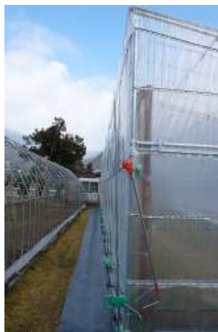
図11 側窓巻き上げ装置の設置状況
