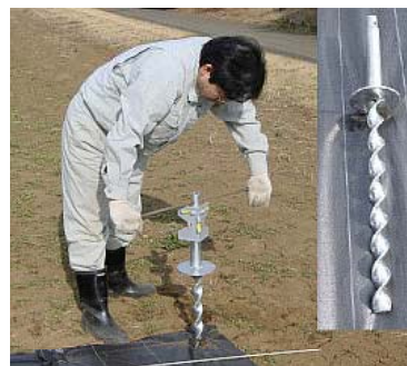
スパイラル基礎杭のねじ込み施工
