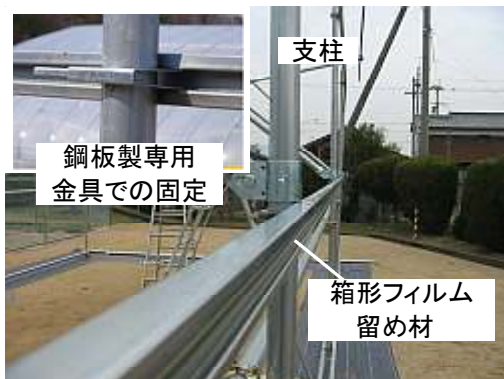
図27 側面へのフィルム留め材取付
