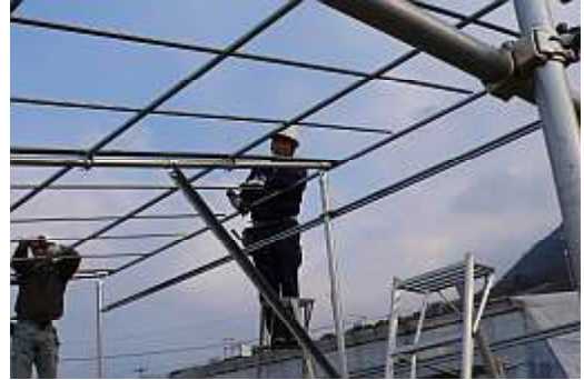
図30 屋根面へのフィルム留め材の固定
