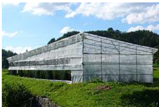
図2 農家が自作した両屋根型のハウス (広島県北広島町西八幡原)
