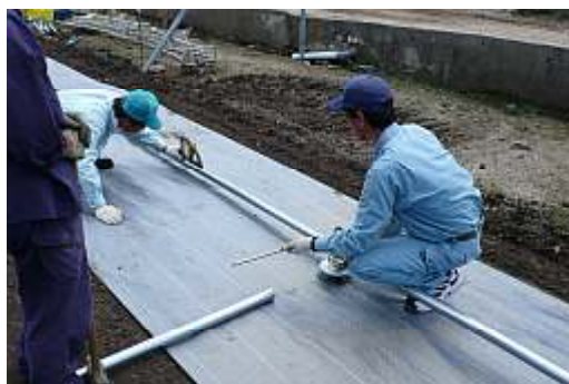
図22 根太パイプの取り付け
