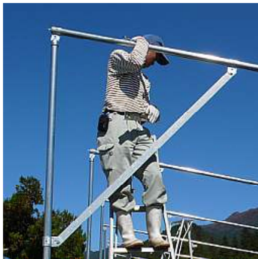
図25 等辺山形鋼による方づえ補強
