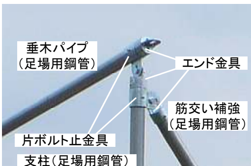
図24 山側支柱と側面筋交い補強の接合 および垂木先端へのエンド金具装着
