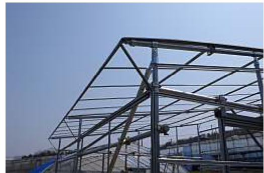
図31 軒先へのフィルム留め材配置
