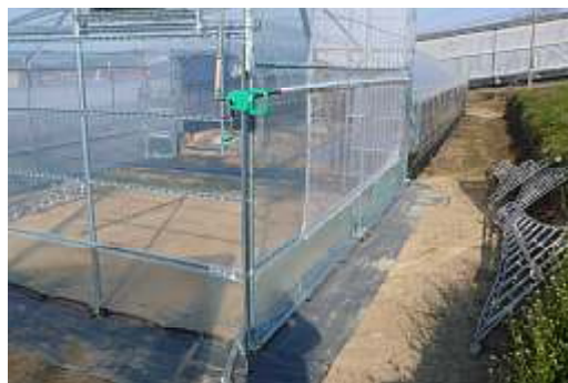
図32 防虫網組込と巻き上げ設置
