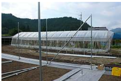
図23 支柱の立ち上げと横パイプの取付
