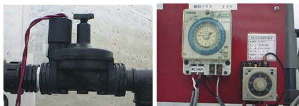
写真3 電磁弁とタイマ
