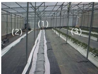
写真4 栽培ベッドの設置作業
