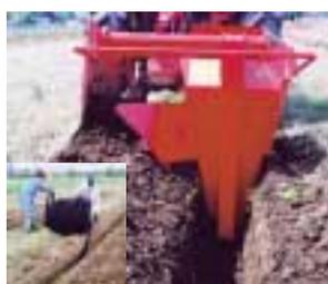
図2 溝掘機による浅層暗渠の施工
