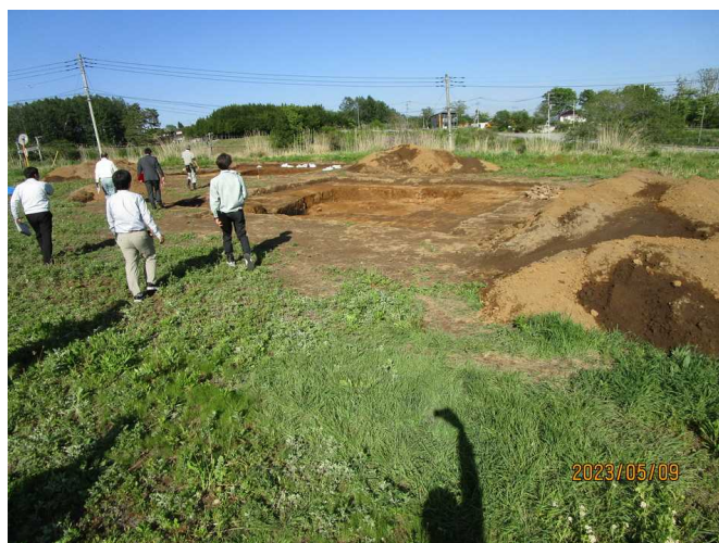
工事（遺跡発掘調査）の進捗確認(出張)
