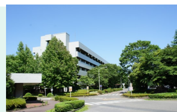
農業環境センターの研究本館
