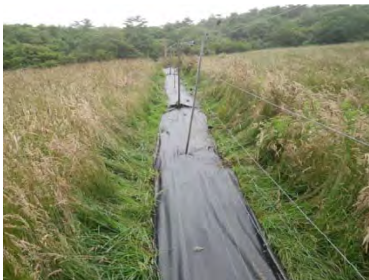
図 1-2-39 恒久電気柵の下部に防草シートを設置して除草作業の軽減化。
