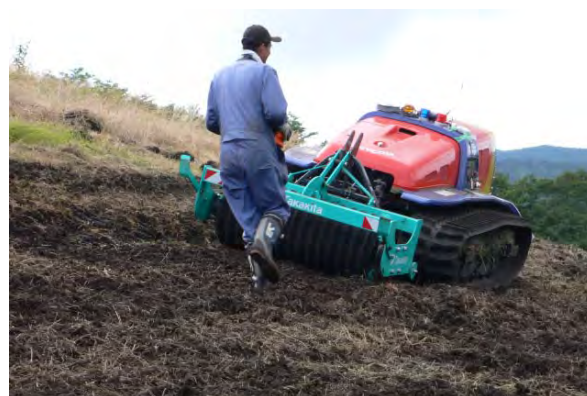
⑤ 鎮圧ローラによる鎮圧
