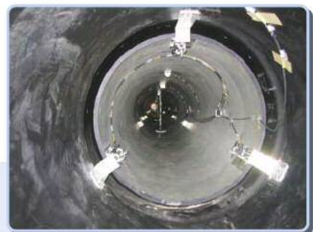
底樋内面 (実証試験用センサー設置)
