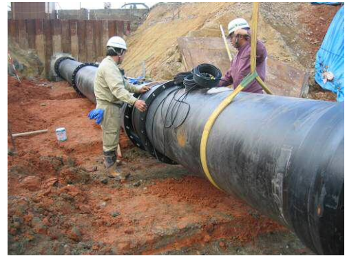
底樋管の接合
