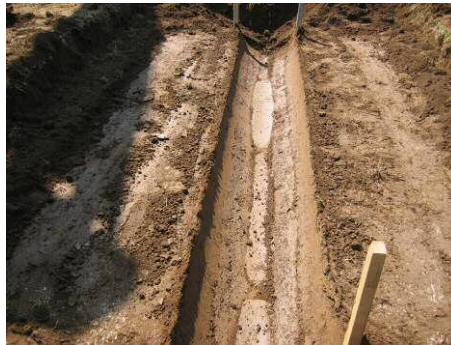
図-4.2.6 通常の手順による締固め結果
