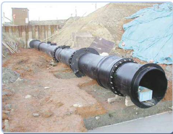
柔構造底樋 (上流側)
