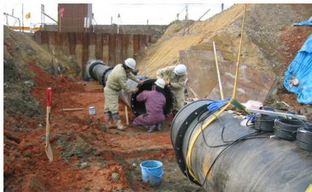
図-3.2.5 柔構造底樋の施工状況
