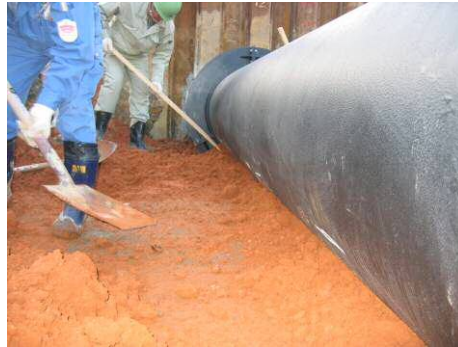
図-4.2.5 管底部の突固め状況
