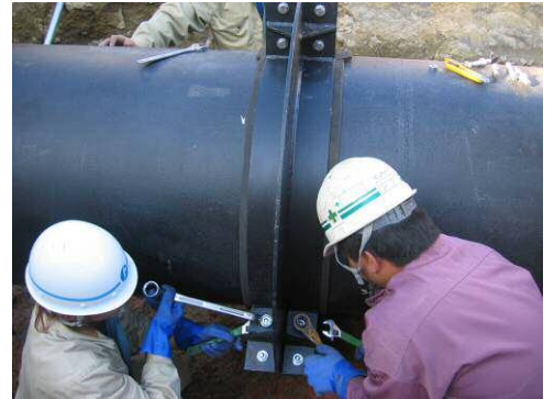
止水壁の設置
