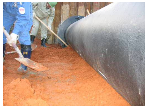
管底部への基礎材投入・締め
