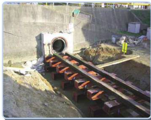
推進工法部分 (下流側)
