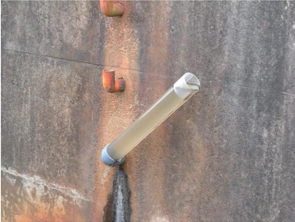
Fig.3 暗渠排水口に立ち上がり管を設置した様子
