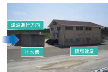
写真1 大破を免れた排水機場
