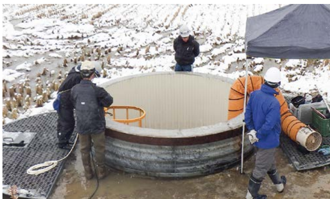
図2 内巻補強後の集水井の状況
