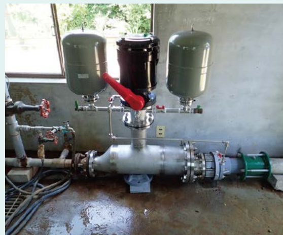
図2 圧力変動緩和装置の設置事例
