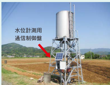
配水槽の水位制御による配水管理
