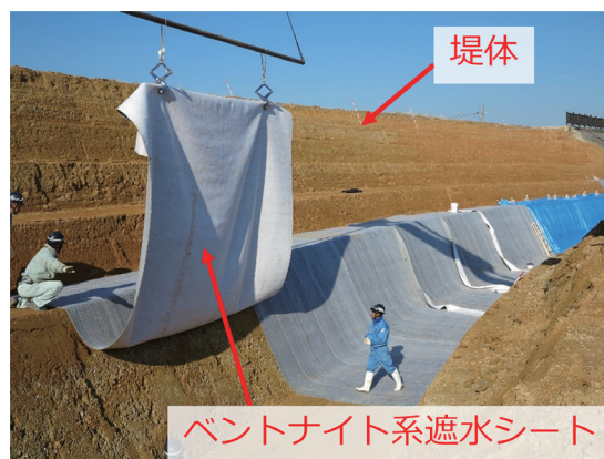
(b) ベントナイト系遮水シート敷設状況
