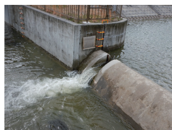
▲図3 洪水吐スリットを設けたため池
