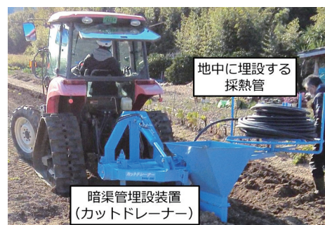
▲図2 暗渠管理設置装置による採熱管埋設
