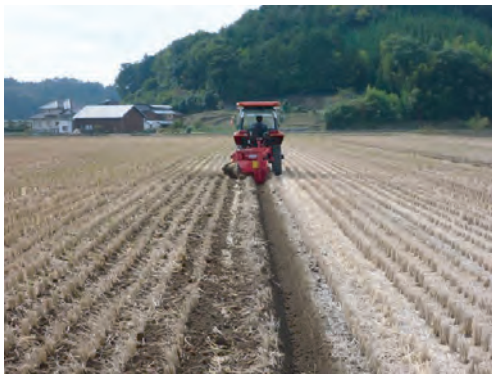
左：基幹排水路、圃場が固い状態で設置（麦播種前） 右：弾丸暗渠（麦播種前）
