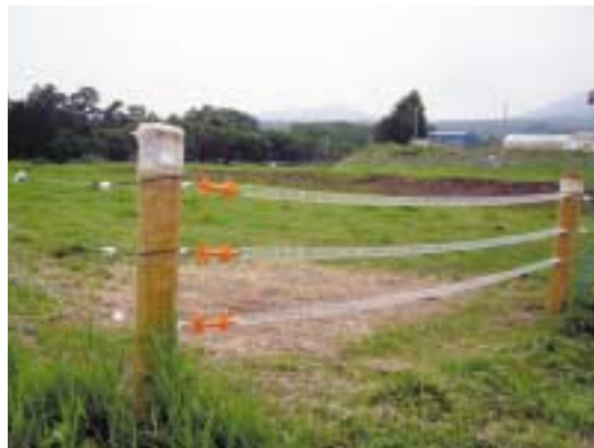
写真8 市販の丸太材を用いた主柱
