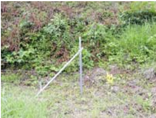
写真15 コーナーの主柱と支え 足場パイプに塩ビパイプを被せて絶縁
