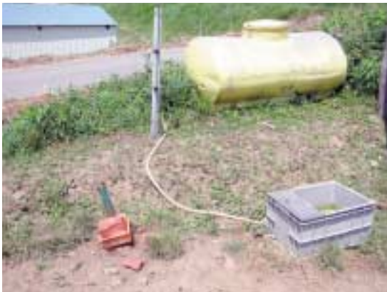
写真19 フロート式水栓付き水槽と 1000ℓのポリタンク
