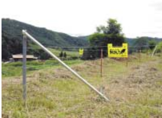
写真7 足場パイプを利用した主柱
