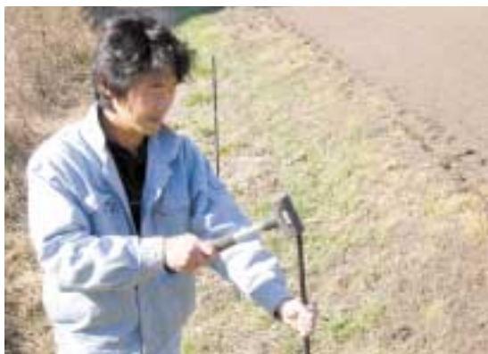
写真17 支柱の打ち込み
